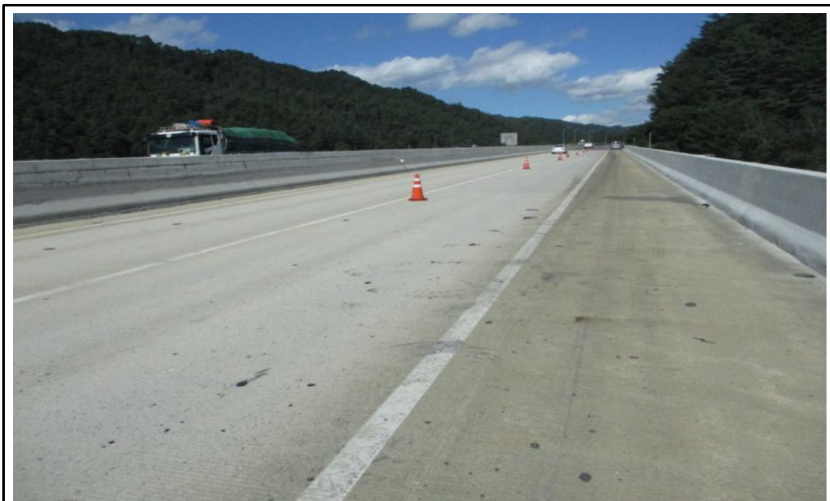
교량 상부 전경
